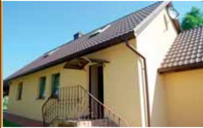
i lokali mieszkalnych na skutek osuwiska
